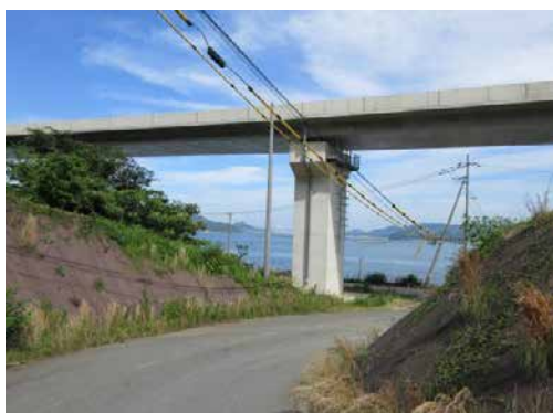
■「三原バイパス系崎8丁目付近」 平成30年6月撮影
