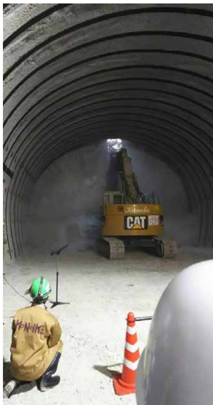
■「赤石トンネル貫通式にて 赤石トンネル貫通の瞬間」 平成29年11月19日開催
